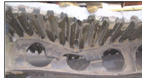
Zbadana postać zniszczenia
